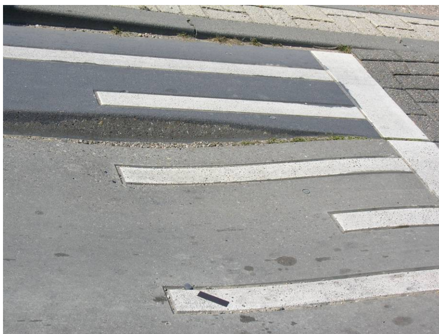
Fot. 4.4. Najazd na powierzchnię spowalniającą o zmiennym przekroju, dostosowanym do różnych rodzajów pojazdów
