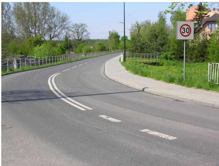
Fot. 3.4. Oznakowanie wjazdu do strefy „30” bez fizycznego wyróżnienia zmiany przekroju drogi
