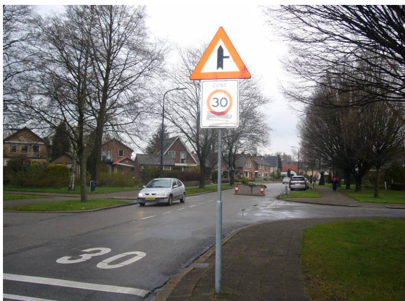
Fot. 4.21. „Brama wjazdowa” do strefy „30” z szykaną wymuszającą spowolnienie ruchu
