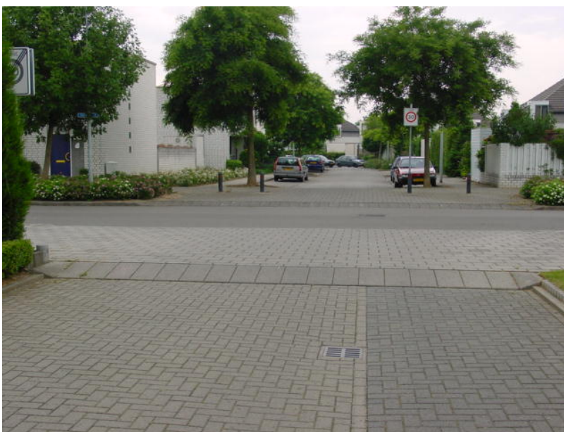
Fot. 4.19. Geometria wyjazdu ze strefy „30”. Chodnik poprowadzony w jednym poziomie wzdłuż drogi zbiorczej (50 km/h) wymusza spowolnienie ruchu na wlocie do skrzyżowania
