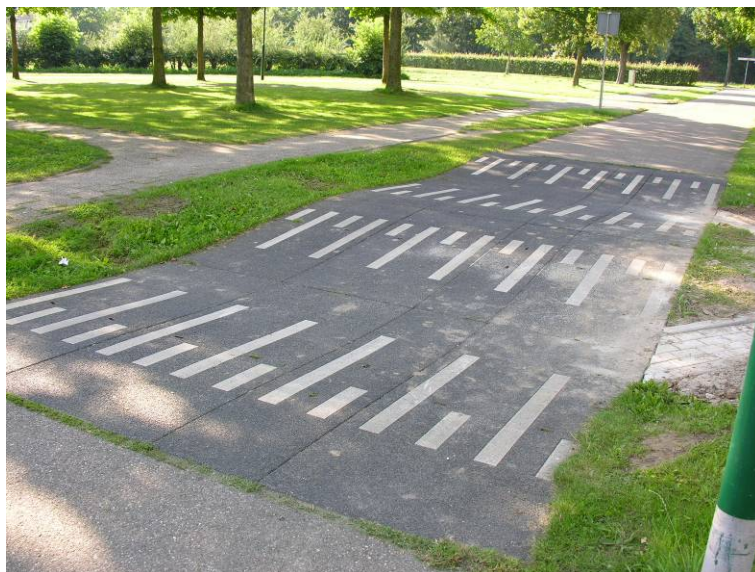
Fot. 4.26. Powierzchnia spowalniająca na drodze dla rowerów
