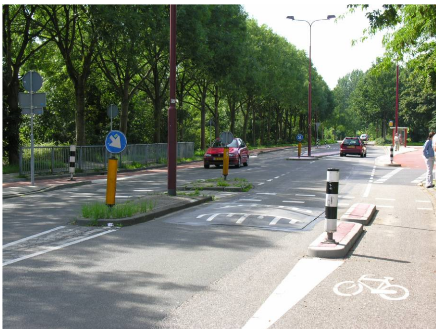
Fot. 4.5. Powierzchnia spowalniająca w postaci tzw. „poduszki”
