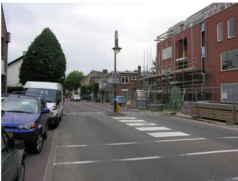
Fot. 4.17. Zmiana przekroju drogi na granicy stref o różnej prędkości dopuszczalnej
