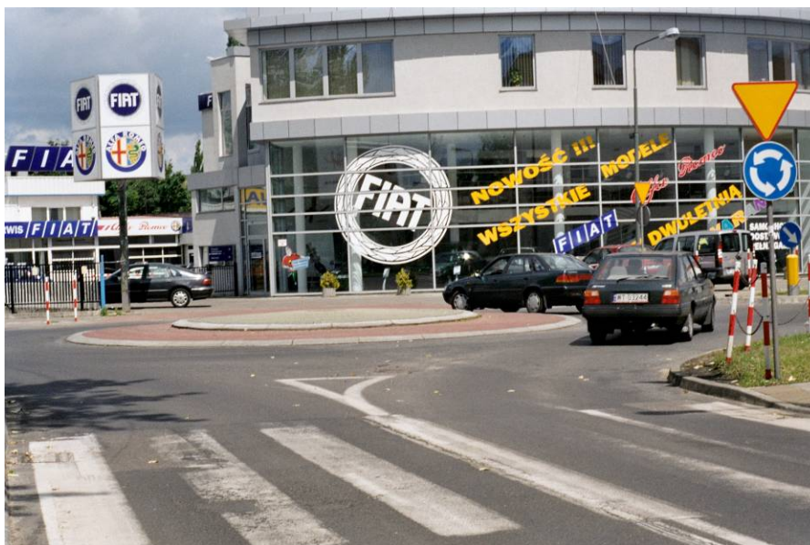
Fot. 4.14. Mini rondo z pierścieniem najazdowym wokół wyspy środkowej
