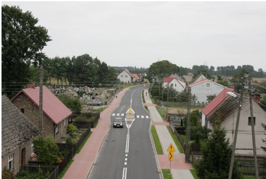
Fot. 3.11. Azyl na przejściu dla pieszych wraz z odgięciem torów jazdy
