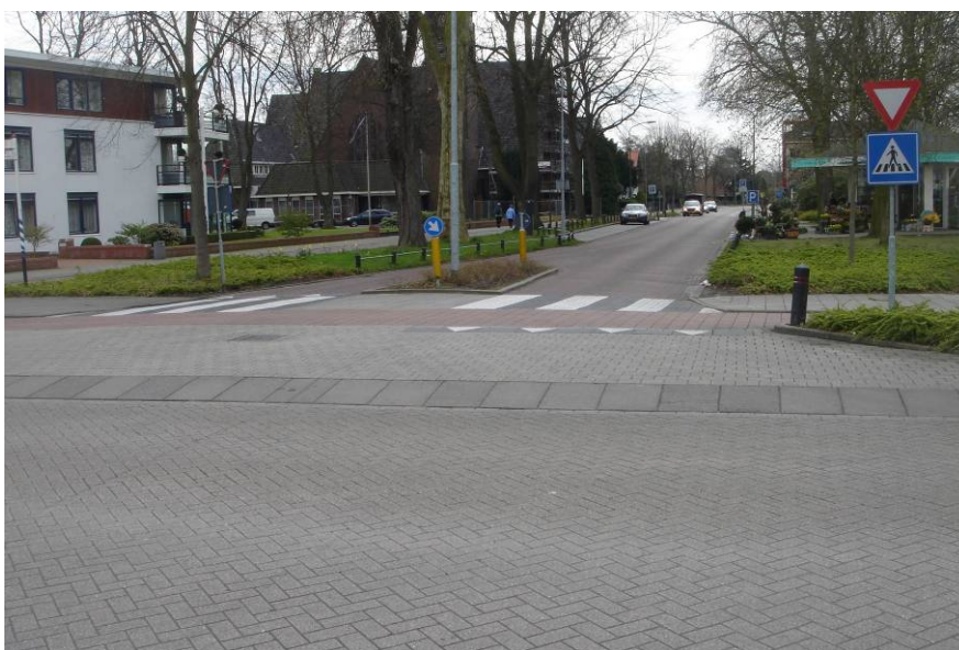
Fot. 3.3. Ukształtowanie skrzyżowania dróg o różnej prędkości dopuszczalnej. Widoczne powierzchnie najazdu wymuszające spowolnienie
