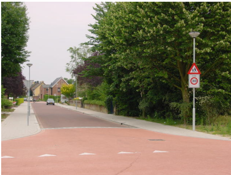
Fot. 4.20. Powierzchnia wyniesiona wyróżniona dodatkowo barwą nawierzchni
