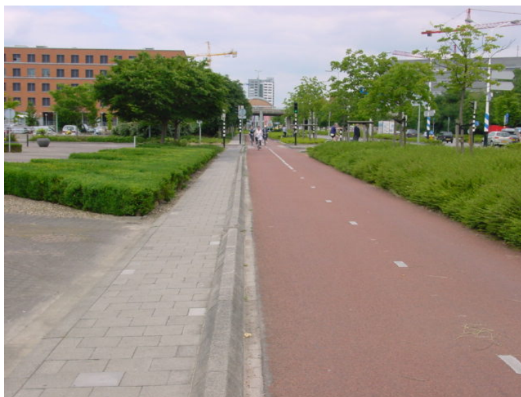
Fot. 4.23. Dwukierunkowa droga rowerowa odseparowana od jezdni (pas zieleni) i chodnika (separatory ruchu)
