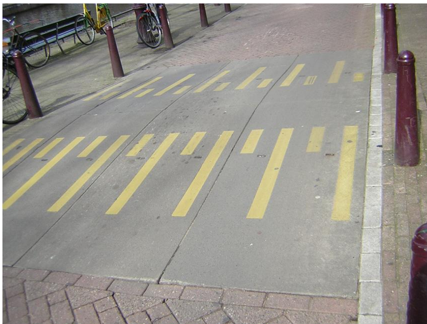
Fot. 4.1. Typowy prefabrykowany próg zwalniający stosowany w Holandii
